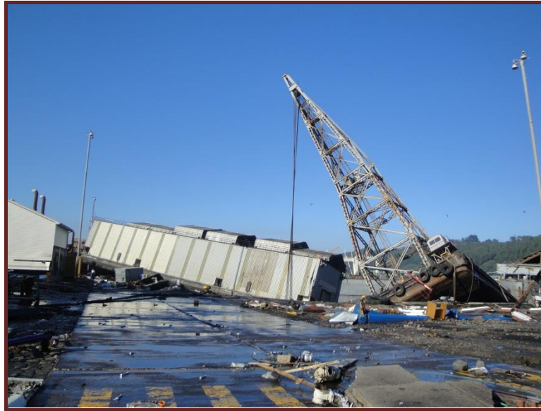
Foto N° 2: Dique flotante “Young” varado por el tsunami sobre el muelle del Astillero de Talcahuano con un submarino en su interior (foto del 27 de Febrero de 2010, 09:33 AM hora local).
