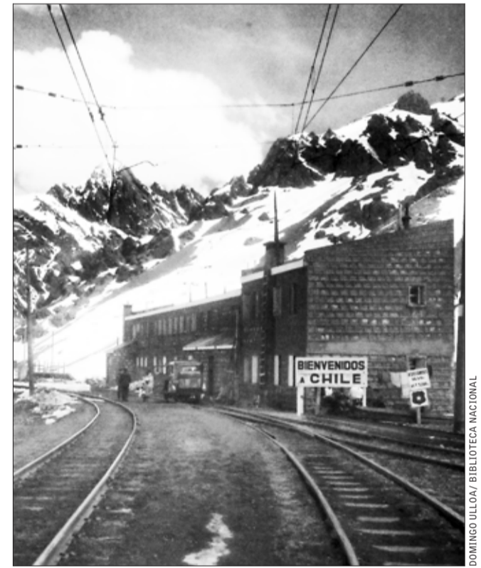
Caracoles (c. 1955) era la última parada del Ferrocarril Transandino antes del túnel internacional. Al inicio de los años 50 se construyó una nueva estación revestida en piedra, donde operaba la aduana.
